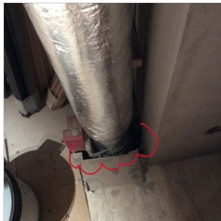
- 1 - CVCD Calfeutrements des tremies au droit du passage des CCF à réaliser
